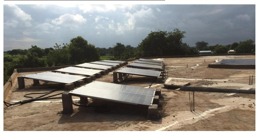
20 panneaux solaires de 280W chacun ont été fixés sur le toit afin de capter les rayons solaires et les transformer en électricité.
