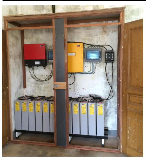
Armoire technique à l'intérieur du bâtiment contenant les batteries, l'onduleur photopholtaïque et l'onduleur chargeur.
