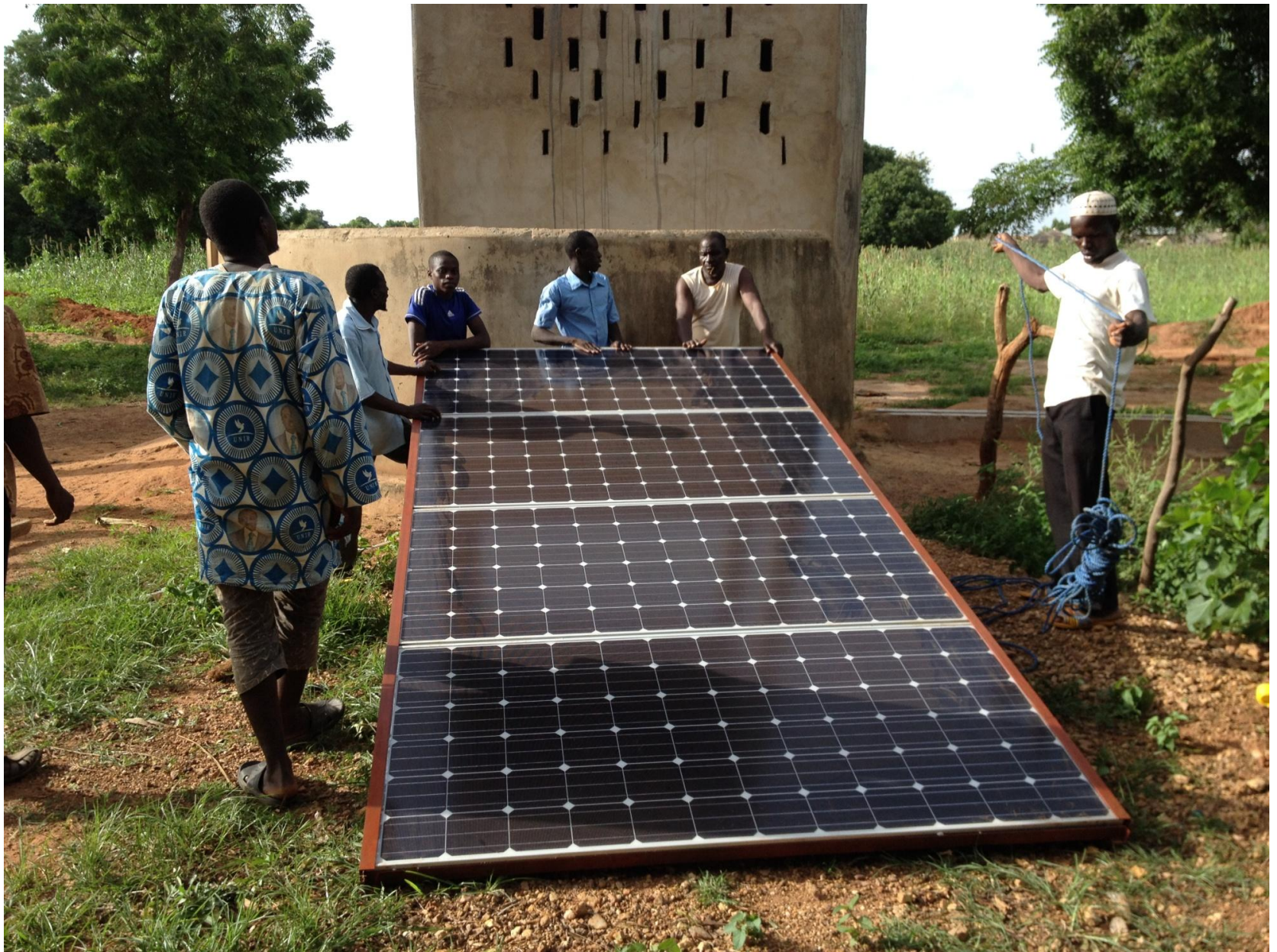
Montage des panneaux solaires sur le château d'eau. 7
