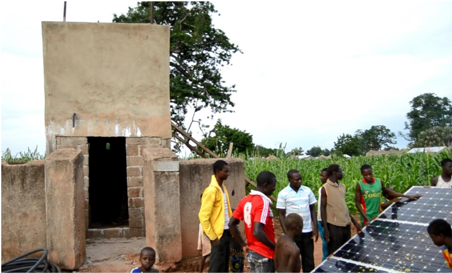
Fixation des panneaux solaires sur le château d'eau. Ces derniers captent les rayons solaires et les transforment en électricité, qui à son tour, fait tourner la pompe immergée pour monter l'eau pure du forage vers le château d'eau.<sup>9</sup>
