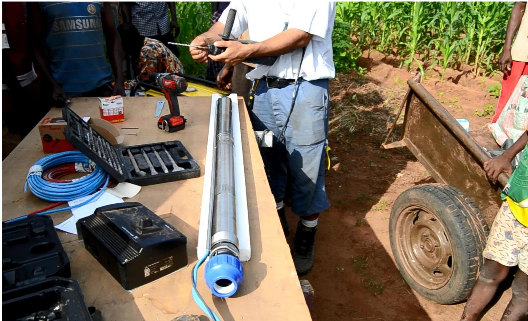
**Mise en place de la pompe immergée au fond du forage, fonctionnant à l'énergie solaire grâce aux panneaux.**
