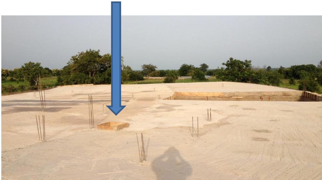
Création d'une trappe dans la dalle pour la récupération des eaux pluviales qui seront stockées dans un bassin de 17 m<sup>3</sup> sous dalle.
