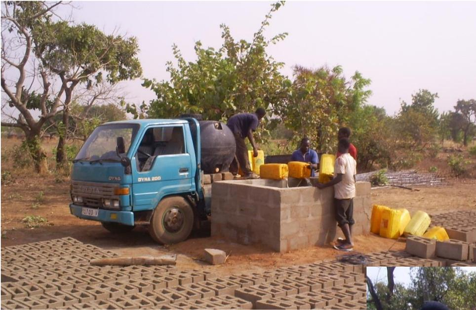
Transport d'eau sur le chantier avec un véhicule, bassin construit spécialement pour la réserve d'eau.
