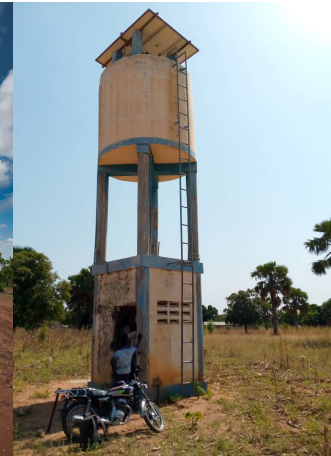
Entretien du château d'eau Nimomogue
