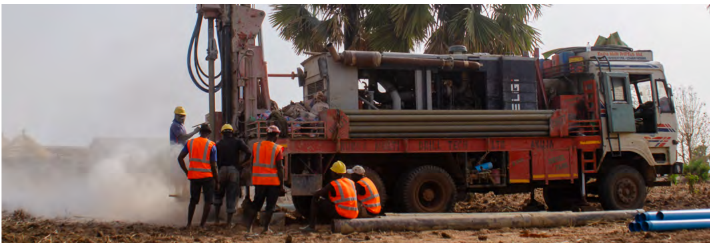
Figure 7 : Forage au village de Malbagou
