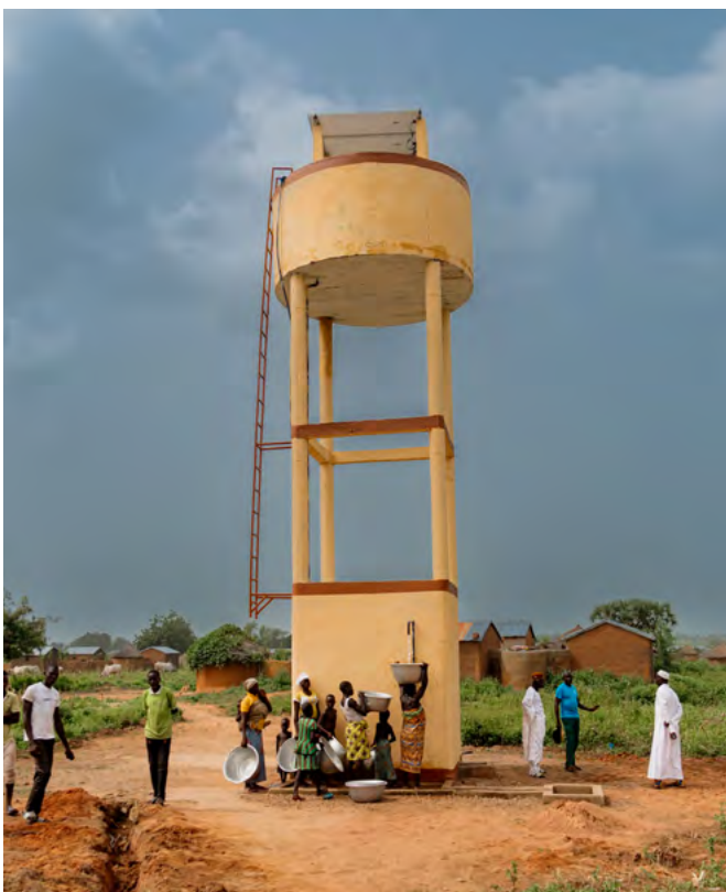
Figure 6 :Château d'eau de Bouldjoaré
