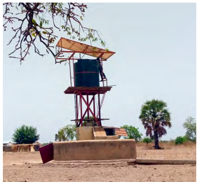
Figure 13 : Intervention au château d'eau de Natchabonga
