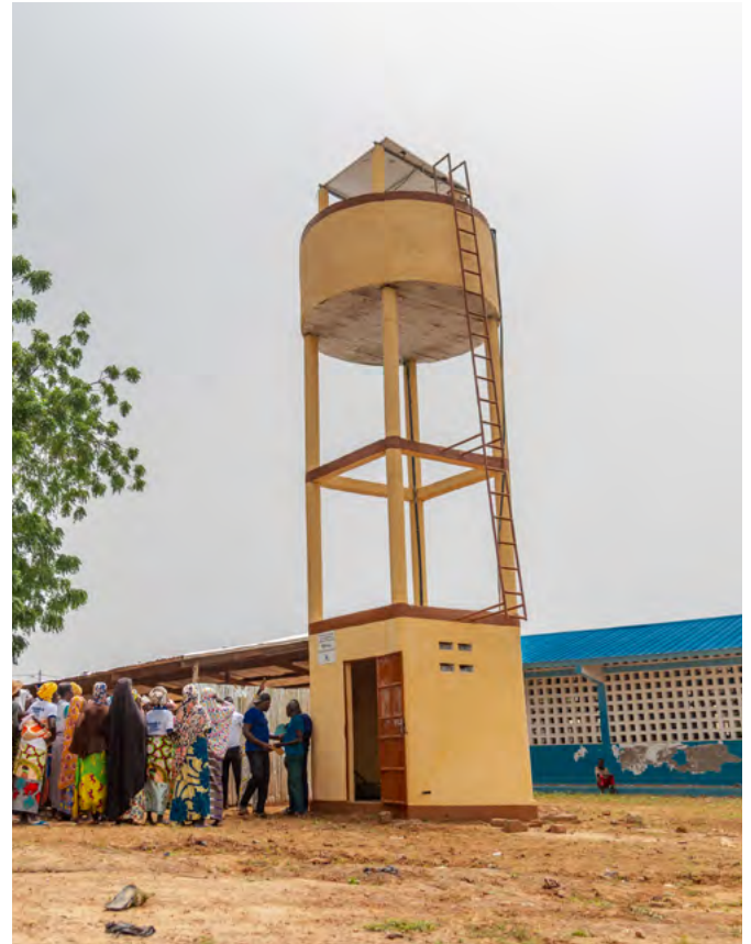
Figure 10 : Château d'eau à Koundjoaré
