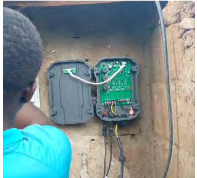
Figure 13 : Intervention au château d'eau de Natchabonga
