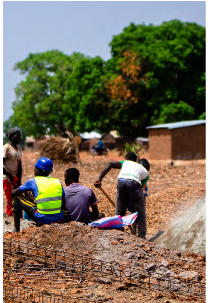
Figure 6: Travaux du château d'eau de Bouldjoaré
