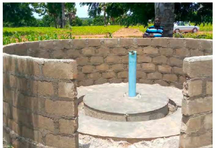
Figure 9 : Travaux du projet de Malbagou
