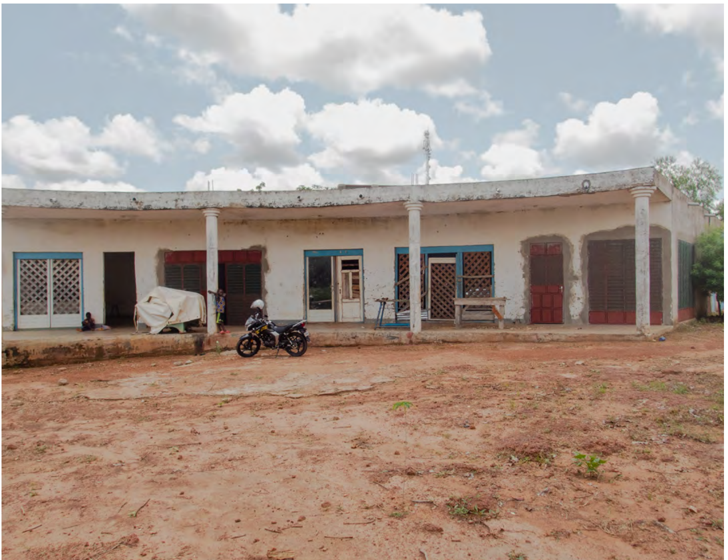
Figure 12 : Bâtiment de Club AIDE à Borgou
