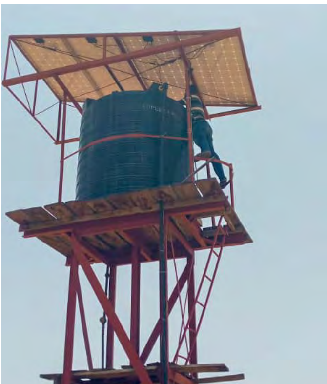
Figure 12 : Intervention au château d'eau de Natchabonga
