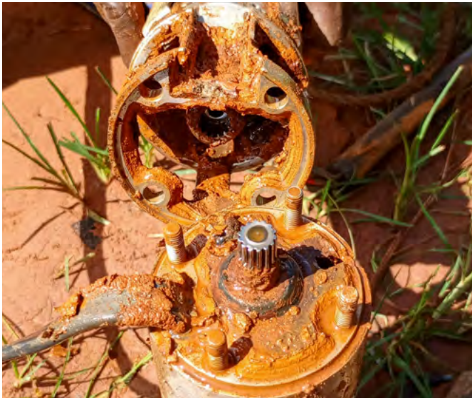
Figure 20 :Entretien de la pompe du château d'eau du chef
